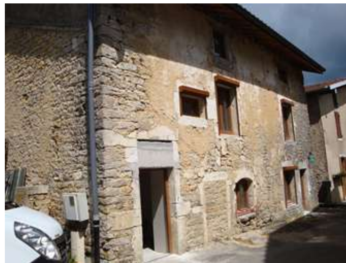
Ferme rénovée avec les caissons des volets roulants en saillie, peu qualitatifs
