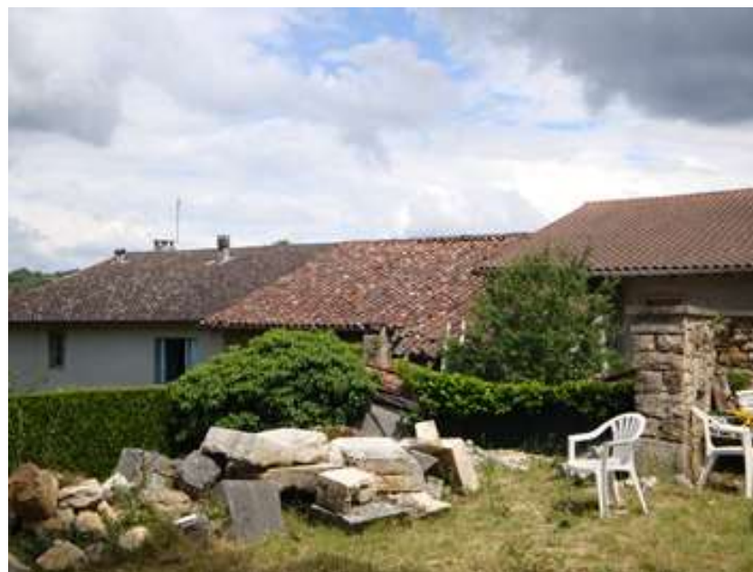
Toitures composite : en tuiles mécaniques, canal ; la tuile « canal » étant la tuile traditionnelle sur ces fermes à faible pente de toit
