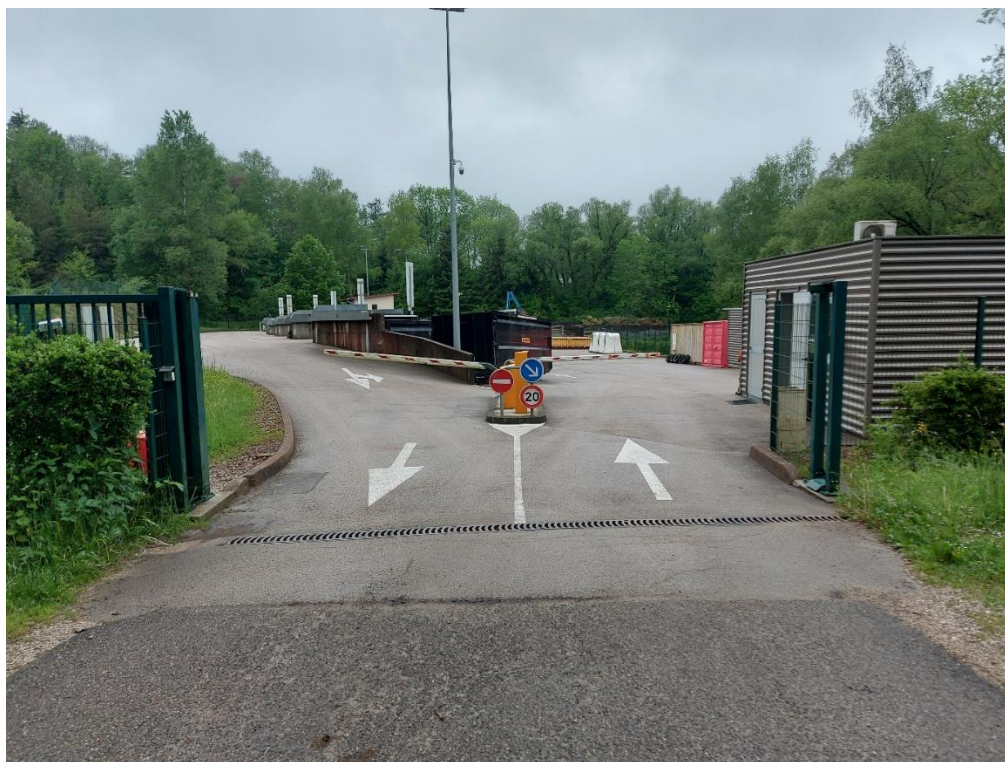
Figure 8 : Photo de la déchetterie de Boissia
