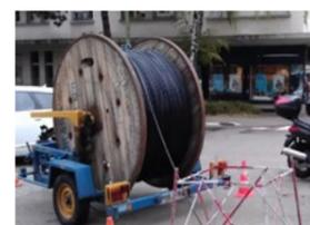
Une fois enroulés, les câbles de fibre optique vont être déployés sur le territoire jusqu'aux logements des abonnés.
