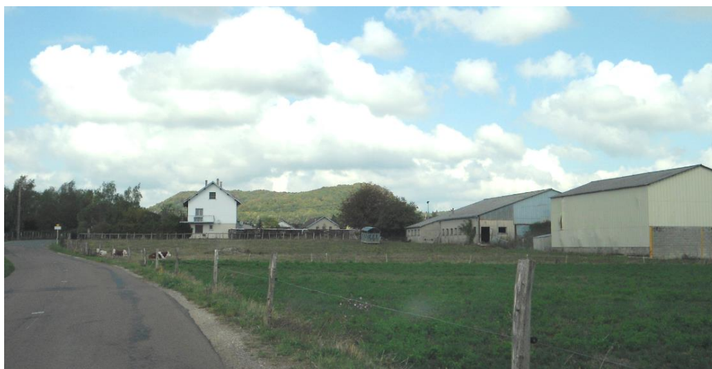
Bâtiments agricoles à l'entrée du village (photographie CA39 – Blye)
