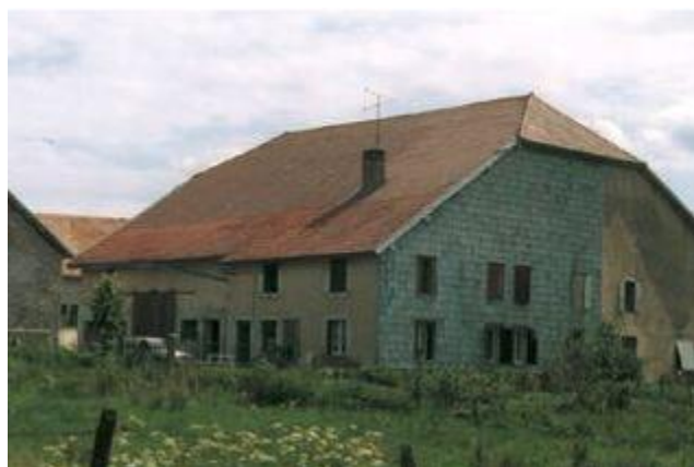
Ferme bloc de volume simple / ferme double (Saffloz - photographie CAUE 1999)
