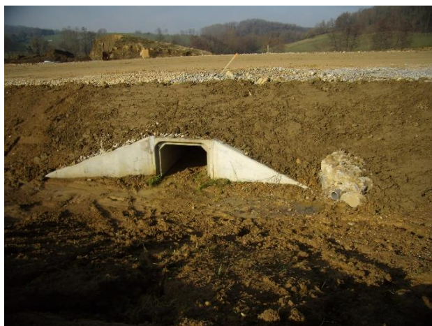
Exemple d'un ouvrage de franchissement pour la faune à Lons-le-Saunier (source : Jura Nature Environnement)
