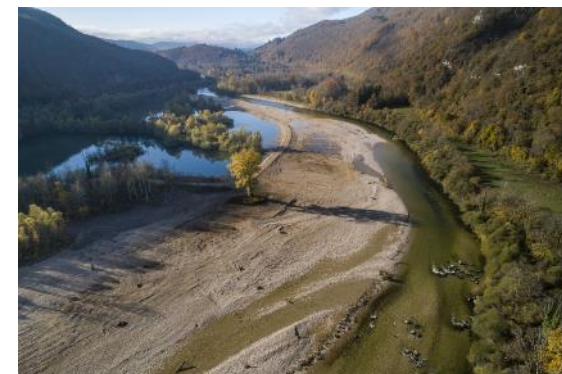
Le site à la fin des travaux, décembre 2021
