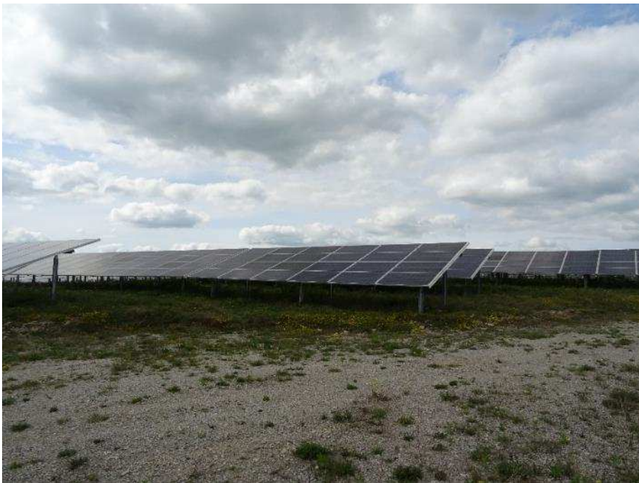
Centrale photovoltaïque de Soucia Source : EVEN Conseil
