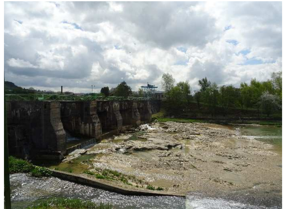
Barrages hydro-électrique de Blye-Charézier Source : EVEN Conseil
