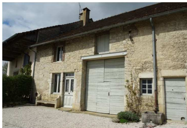
Ferme bloc à trois travées à Mesnois
