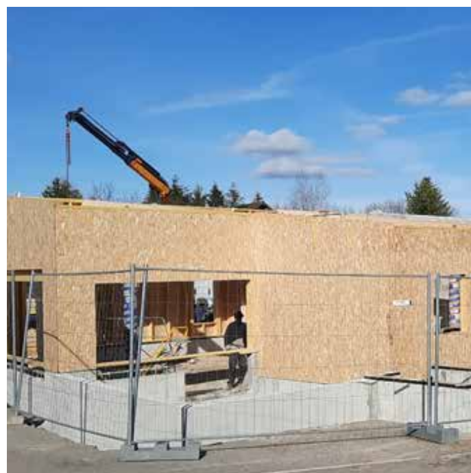
Crèche Poids de Fiole : Les travaux de la crèche ont démarré en novembre 2020.
