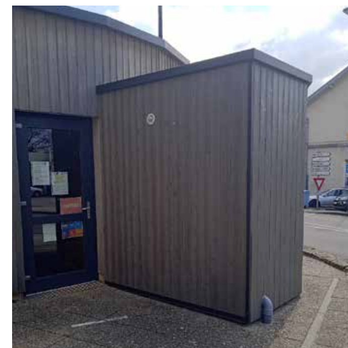
Création d'un WC au point I d'Orgelet : Travaux entièrement réalisés en régie par l'équipe d'Orgelet
